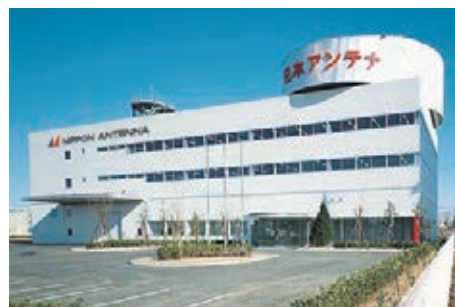
テクニカルセンター(川里工場)
